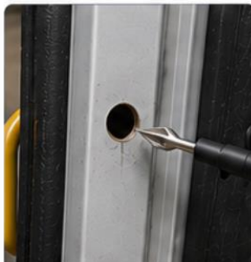
2 Loch mit Ø11mm bohren, entgraten und versiegeln
